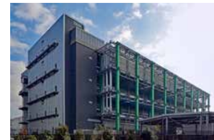
資料中心 Mitsui Fudosan Industriail Park印西II (MFIP印西II)
