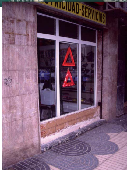
Fig. 28. A. Situación de la antigua laguna del Almarjal (Cartagena) con las sucesivas etapas de desecación desde el siglo XVI en adelante. B. Imagen actual del barrio, habitualmente afectado por inundaciones tras lluvias torrenciales, hecho para el que ya están preparados sus habitantes (Fotografía: Jose A. Ortega) .
