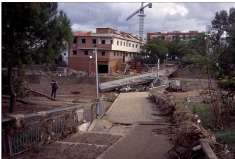
Fig. 26. Efectos de la ocupación del dominio inundable en el barrio de Cerro de Reyes (Badajoz) con el resultado de la sobreelevación de los calados por constricción de las viviendas (Fotografía: Jose A. Ortega).
