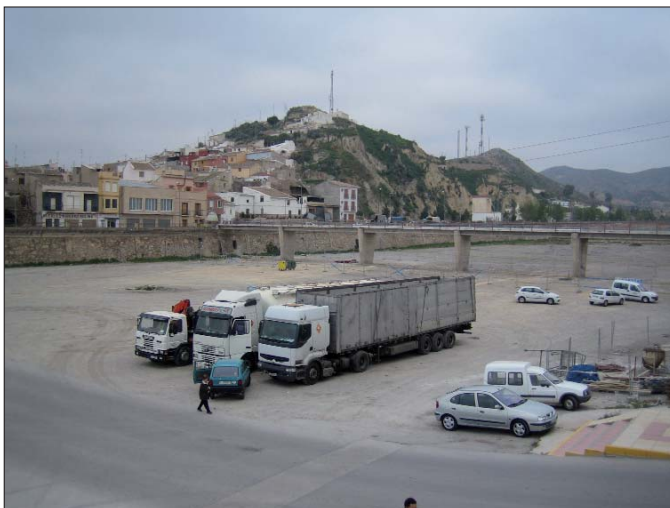
Fig. 34. Aparcamiento en el cauce de la rambla de Nogalte en el municipio de Puerto Lumbreras (Murcia), que ya en 1978 provocó una de las mayores tragedias por una catastrófica avenida. También puede observarse el paso a nivel en la rambla (Fotografía: Jose A. Ortega).
