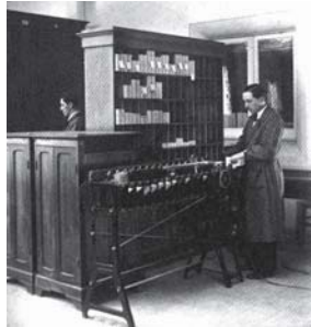
La macchina di Herman Hollerith e il censimento americano del 1890. L'esperto di statistica Herman Hollerith inventò un sistema per rappresentare nome, età, sesso, indirizzo e altri dati personali sotto forma di fori praticati su una scheda e contati poi elettricamente. Il successo nel censimento fece sì che le macchine di Hollerith fossero impiegate anche nei censimenti austriaci e norvegesi e nel primo censimento della storia russa, nel 1896.
