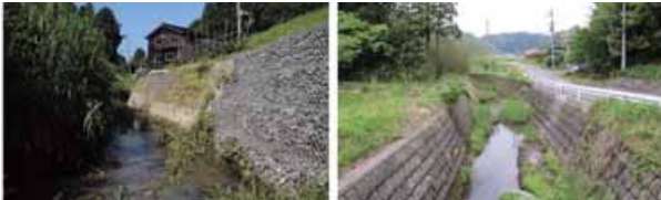
図 39. 河川改修が迫るイシガメ生息地 左) 新たな工事計画があるブロック護岸や蛇籠護岸の川 右) 近くのイシガメが住めない三面護岸の川
