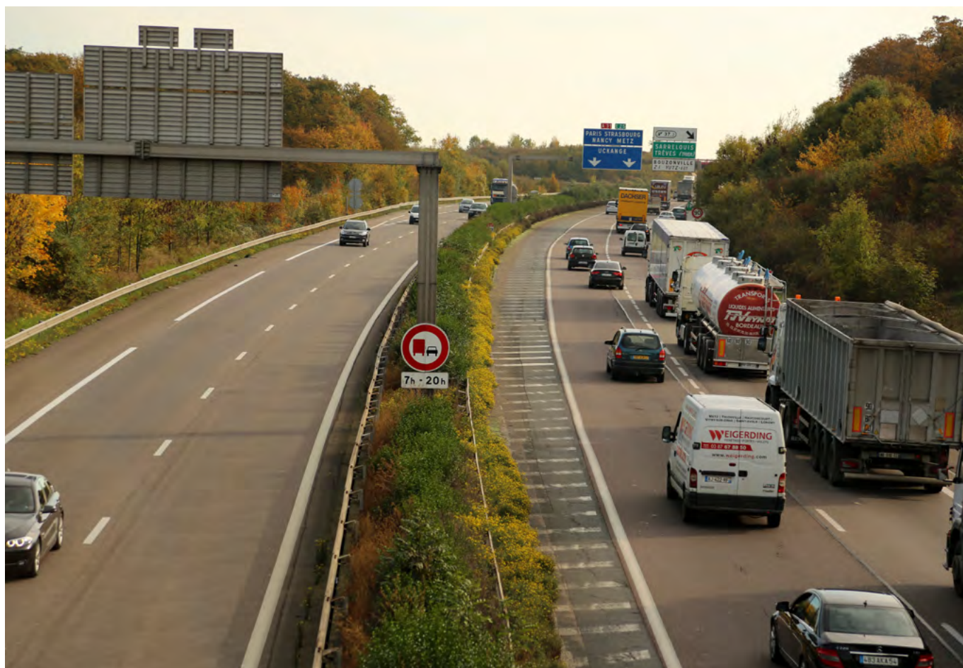
Figure 80. L'A31 actuelle au niveau d'Illange (sortie 37.2)
