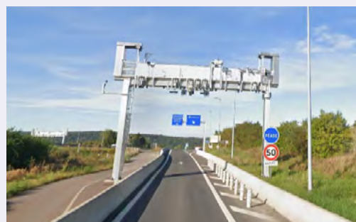
Figure 51. Portique péage en flux libre Boulay
