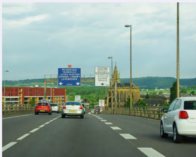
Figure 12. L'A31 dans sa traversée de Thionville
