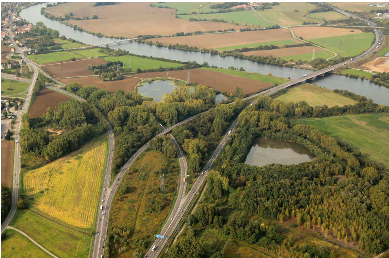
Figure 70. La traversée de la vallée de la Moselle par l'A31
