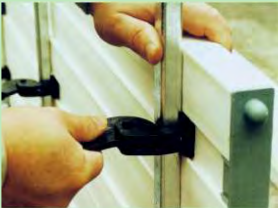
Con las llaves excéntricas se logra un nivelado exacto en un tiempo mínimo.
