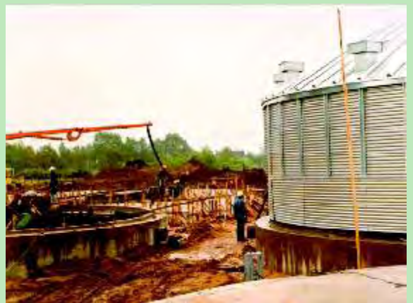
Imágen de una cimentación de 1,30m de altura para silos.
