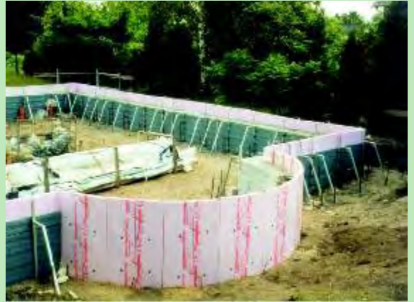
Cimientos de una vivienda familiar.
