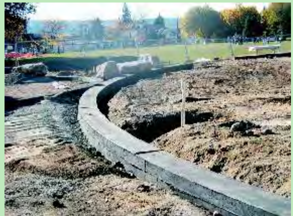
Después de retirar el encofrado.
