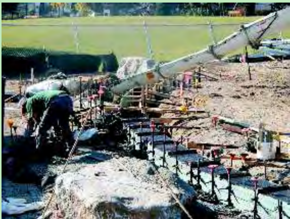
Durante el hormigonado.
