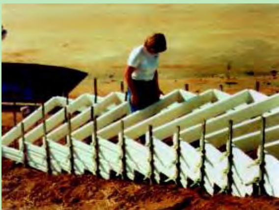
Syflex® empleado en el encofrado de escaleras.
