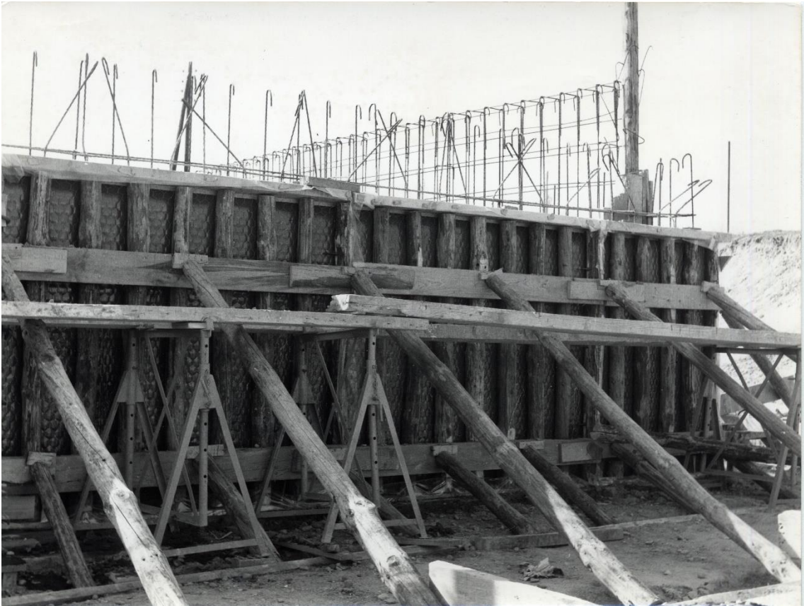
Encofrado con rollizos y malla de gallinero
