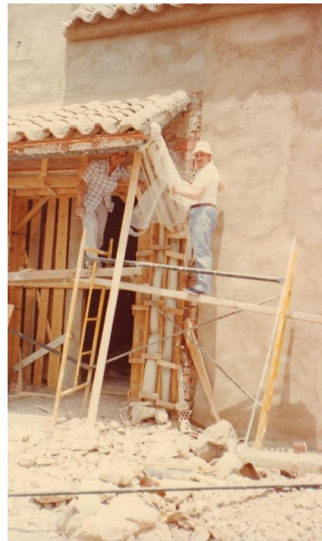
Fisac pintando en el interior de la ermita y colocando los encofrados de las piezas de fachada
