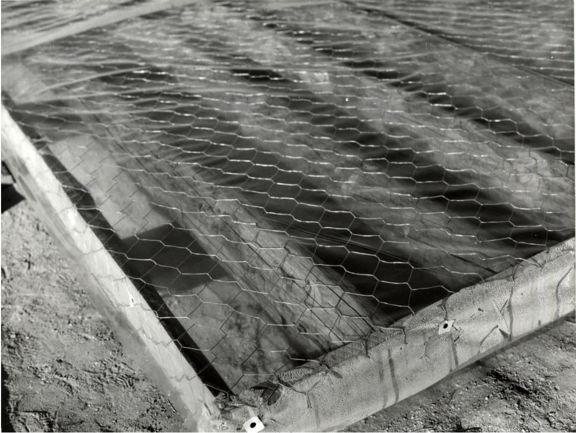
Encofrado con rollizos y malla de gallinero
