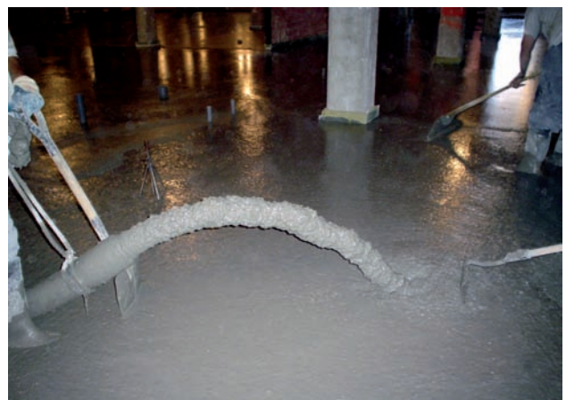
Figura 2.- Puesta en obra del hormigón autocompactante, mediante bombeo.
