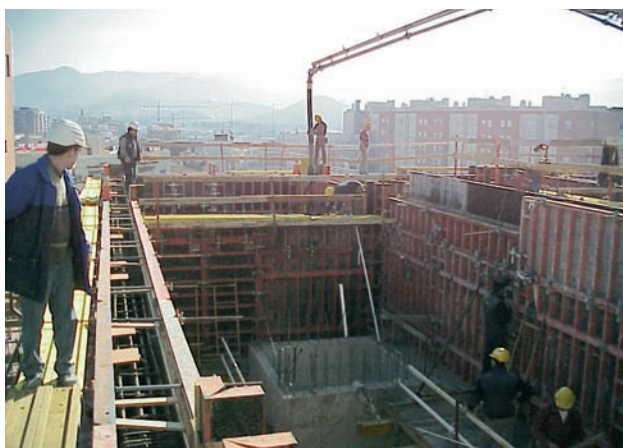
Figura 4.- Encofrado y colocación de hormigón autocompactante mediante bombeo tradicional.
