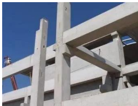
Pórticos de hormigón armado
