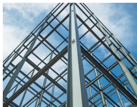
Pórticos de acero
