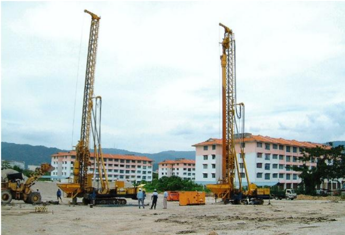
Figura 16. Equipos vibrocat vía seca con descarga interior, en obra.
