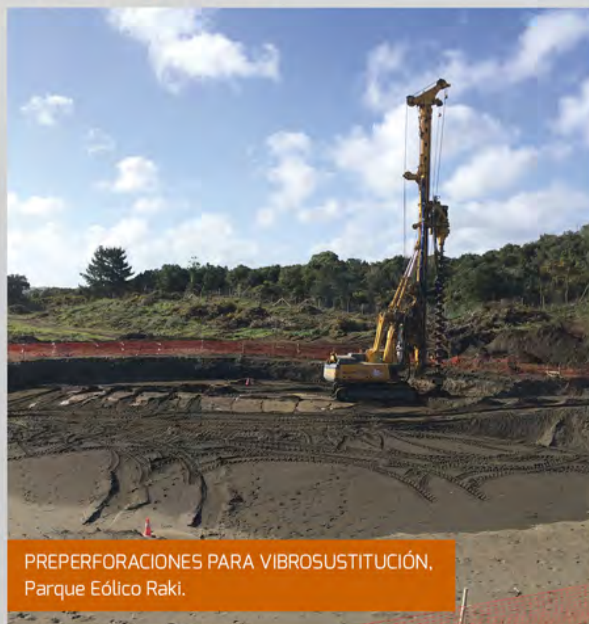
COLUMNAS DE GRAVA, Parque Eólico Raki.
