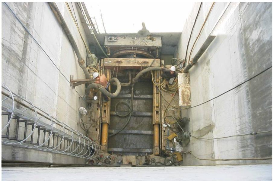
Se utilizan cilindros hidráulicos muy potentes para empujar los tubos especialmente diseñados, a través del suelo, detrás de un escudo, al mismo tiempo que se lleva a cabo la excavación dentro del escudo. El método provee una tubería flexible, estructural y hermética mientras el túnel va siendo excavado.
