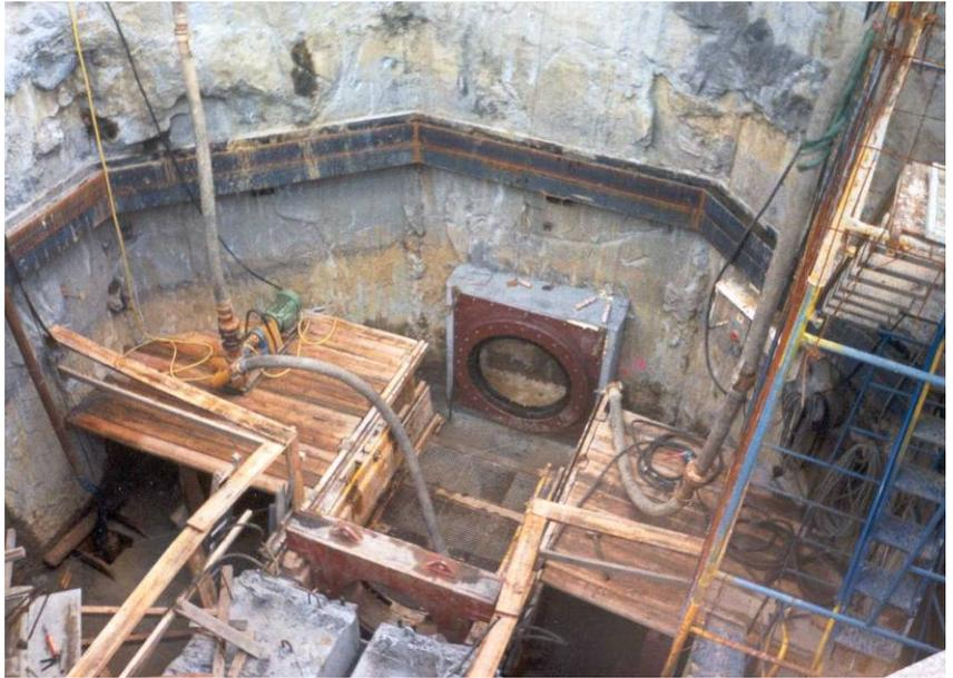
La evacuación del material excavado se realiza mediante  **transporte hidráulico** , por lo que será necesario contar con un  **sistema de bombeo y conducciones** , que inyecte agua o bentonita que actuará como vehículo de transporte del material excavado, y que guíe la papilla resultante hasta un  **decantador**  que nos permita reutilizar el agua o bentonita, e ir separando el material excavado, funcionando todo el sistema en circuito cerrado, reduciendo por tanto, las aportaciones de líquido.
