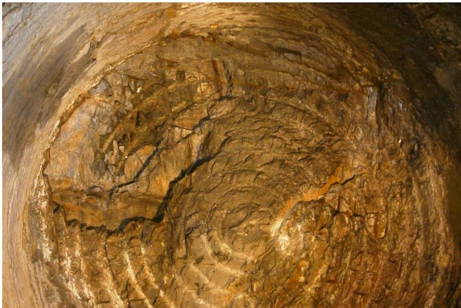
b) **Roca granítica:** A diferencia de la roca caliza, el granito ejerce un fuerte desgaste sobre los discos de corte (debido a la presencia de la sílice libre) lo que limita las distancias de hincadora, o exige el cambio de
