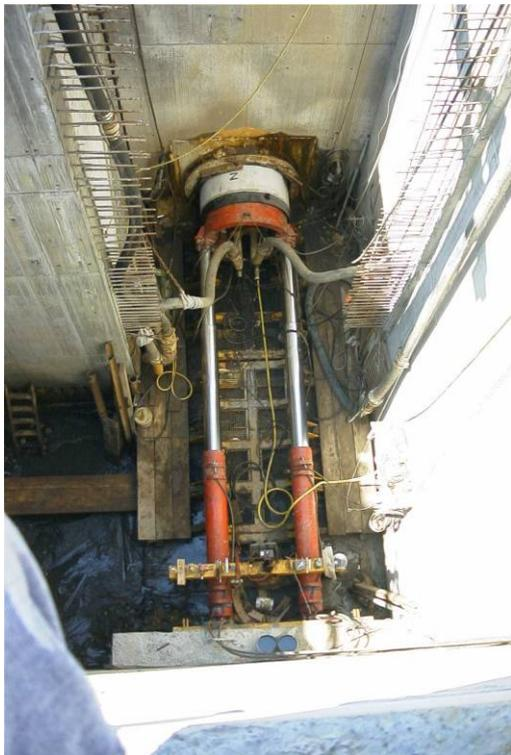
En el fondo del pozo de ataque y en el extremo opuesto a la boca del túnel se construye un muro de reacción, de resistencia mínima 600 Tm., contra el cual presionar.
