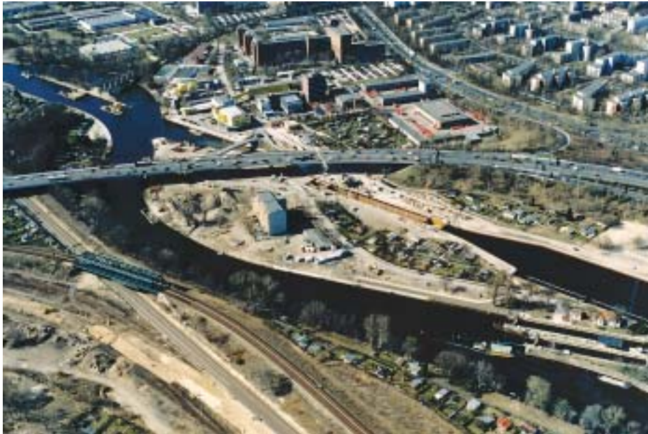
Blick auf die Baustelle der neuen Schleuse Charlottenburg, aufgenommen im März 2003
