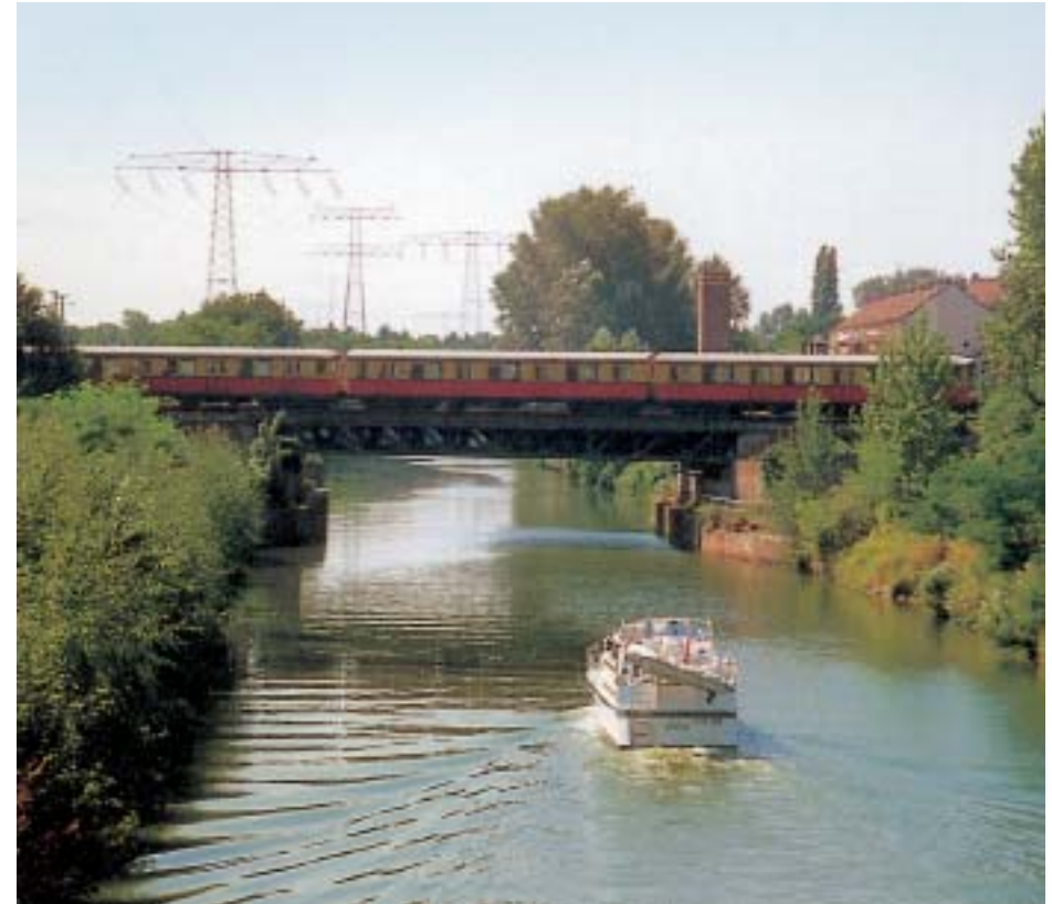
Eisenbahnbrücke über den Britzer Verbindungskanal bei km 31,09 a
