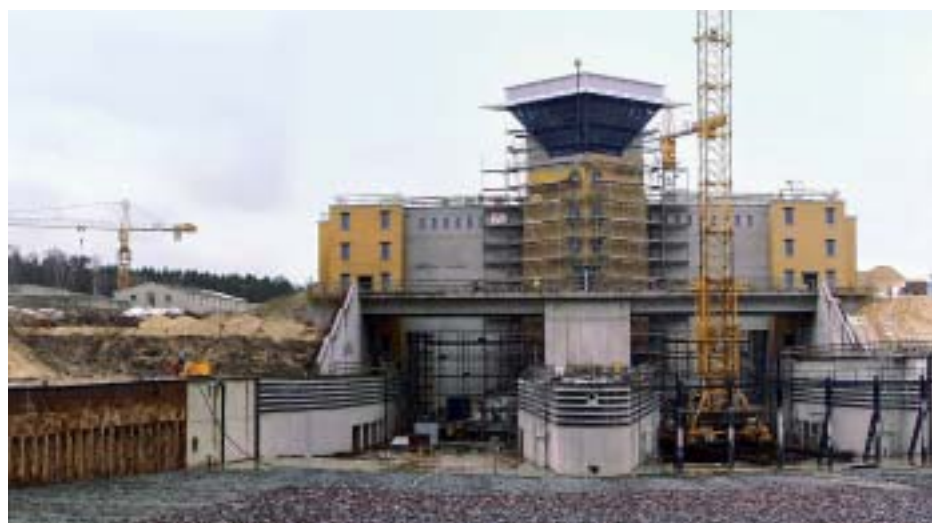
Blick auf die im Bau befindliche Doppelschleuse Hohenwarthe
