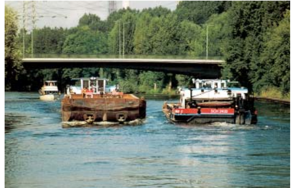
Trasse Nord im Bereich der Spree-Oder-Wasserstraße
