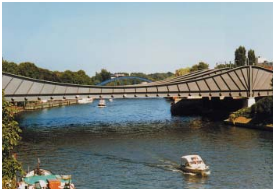
Neue Eisenbahnbrücke über die Spandauer Havel
