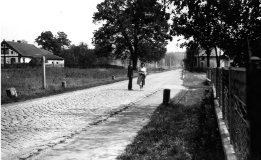
Fot. 36 Widok na ul Rudzką i kapliczkę od ul. Ofiar Oświęcimskich (z archiwum Z. Weinera).
