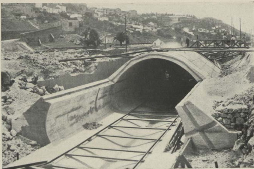
PORMENOR DA CONSTRUÇÃO — SOLEIRA, ENCONTROS E ABÓBODA
