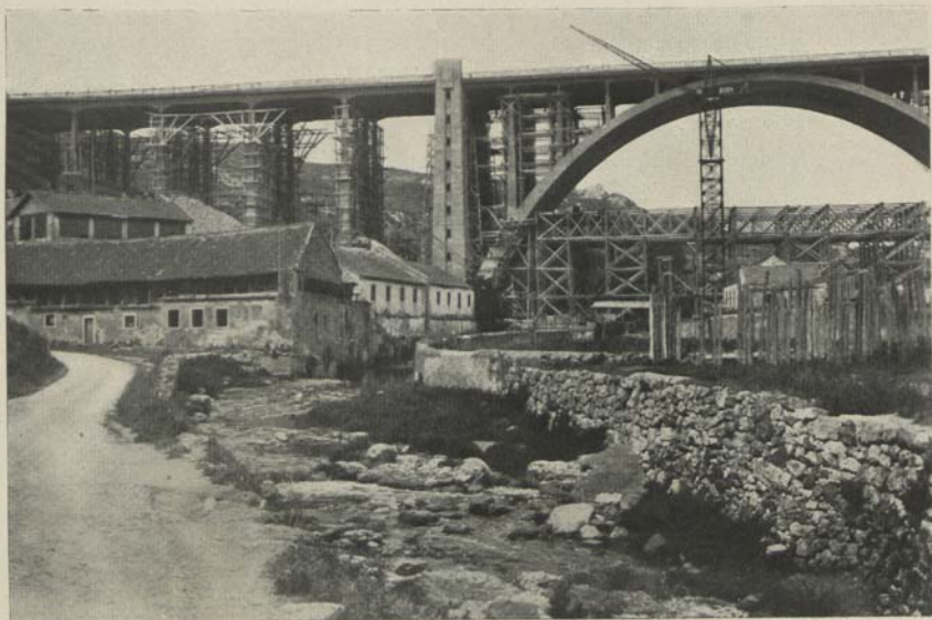
TRECHO DO CANEIRO JUNTO DO VIADUTO DUARTE PACHECO
