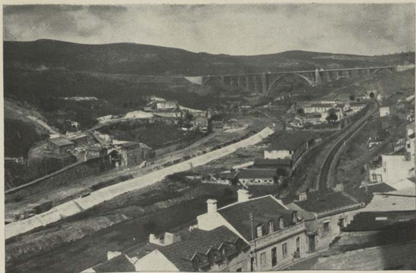
VISTA GERAL DA CANALIZAÇÃO TIRADA DE CAMPO DE OURIQUE
