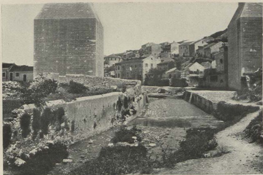
PASSAGEM DO CANEIRO SOB O ARCO GRANDE DO AQUEDUTO DAS ÁGUAS LIVRES
