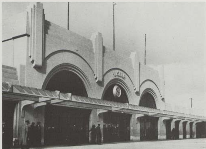
Aspecto da fachada da Estação Sul e Sueste, no Terreiro do Paço, em Lisboa, onde está bem patente a sobriedade e solidez dum edifício modernista, composta por três arcos de volta inteira, geometrização muito marcada, construída em betão, aspectos notórios dum edifício modernista, projectado pelo arquitecto Cottinelli Telmo, em 1931
