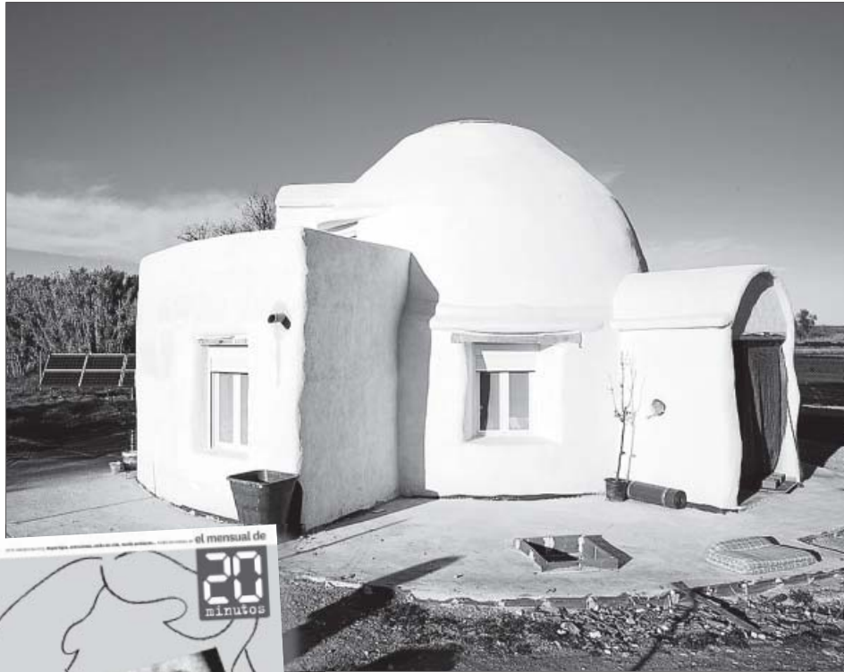
Construcción en superadobe en un terreno cerca de Madrid. E. BUENAVISTA
