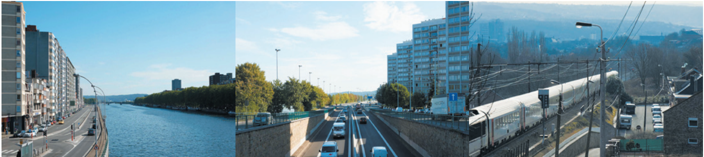
Les ruptures dans le centre de l'agglomération liégeoise : des voies rapides le long des quais et des voies de chemin de fer à l'intérieur des terres © photographies : Alain Janssens
