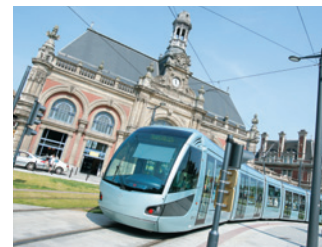
→ TRAMWAY SUR RAILS Valenciennes
